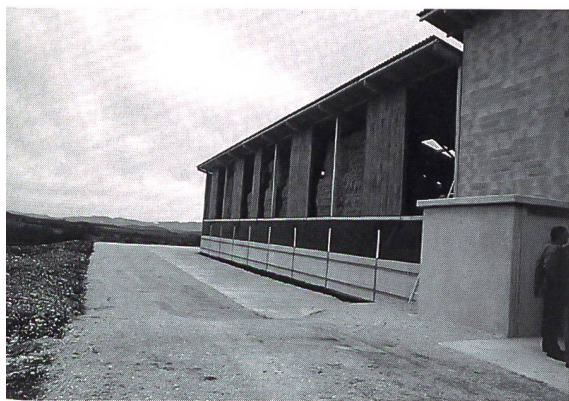
Befestigter Umschlagplatz, Optimierung des Stallklimas durch Windschutznetze, Strohlagerung über dem Tiefstreu-lager.
