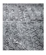
einer 5 bis 10 cm mächtigen Kiesschicht als Unterbau auch der Bodenbefestigung auf einem Hofplatz dienen und ist dann auch für das Befahren und Abstellen von Traktoren und LKW geeignet. Die Stabilität der Lochplatten wird durch Befüllung von Splitt in die Öffnungen zusätzlich verbessert. Der grosse Vorteil der Platte ist auch der Umstand, dass Meteorwasser an Ort und Stelle versickern kann. Preis zirka Fr. 25.—pro m².
