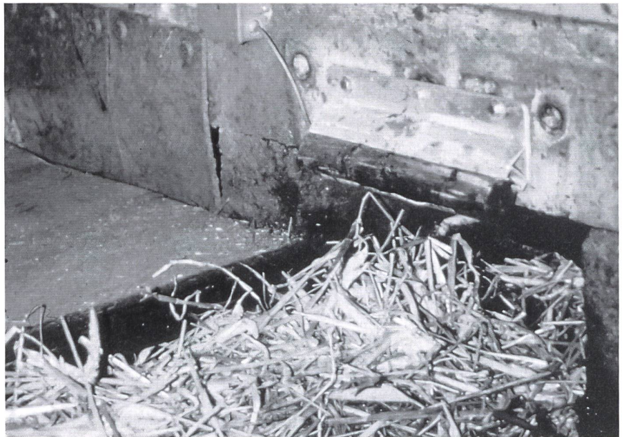
Abb. 8. Können bei Entmistungsanlagen die Sicherheitsabstände nicht eingehalten werden, so sind an Gefahrenstellen Kontakteinbauten einzubauen.
