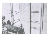
Bei den Spannbeton-Güllesilos werden die Wände aussen mit Drahtseilen vorgespannt, um so den Druck von der Gülle im Silo auszugleichen. (Bild A. Moser)
