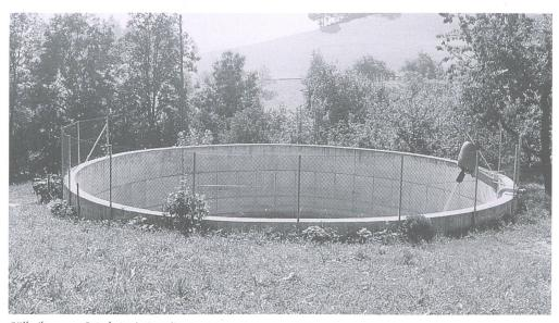
Güllesilo am Ort betoniert mit Paddel- bzw. Tangentialrübrwerk.
