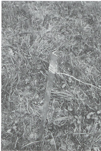
Abb. 8. Eine gute Erdung besteht, wenn der elektrische Kontakt zwischen der Sonde und dem Apparat ohne grosse Widerstände (Rost, loser oder zu dünner Draht) vorliegt.
