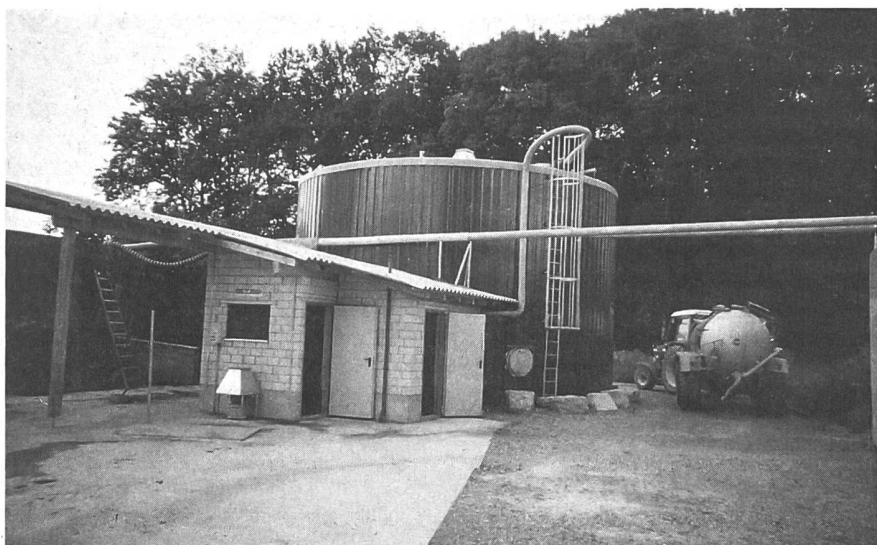
Co-Vergärung: In der Biogasanlage auf dem Brüederhof in Dällikon (ZH) werden nebst Hofdünger zusätzlich Gemüseabfälle vergärt. Für die Verwertung der Abfälle bezieht der Betreiber Entsorgungsgebühren. (Inbetriebsetzung: Herbst 1993)
