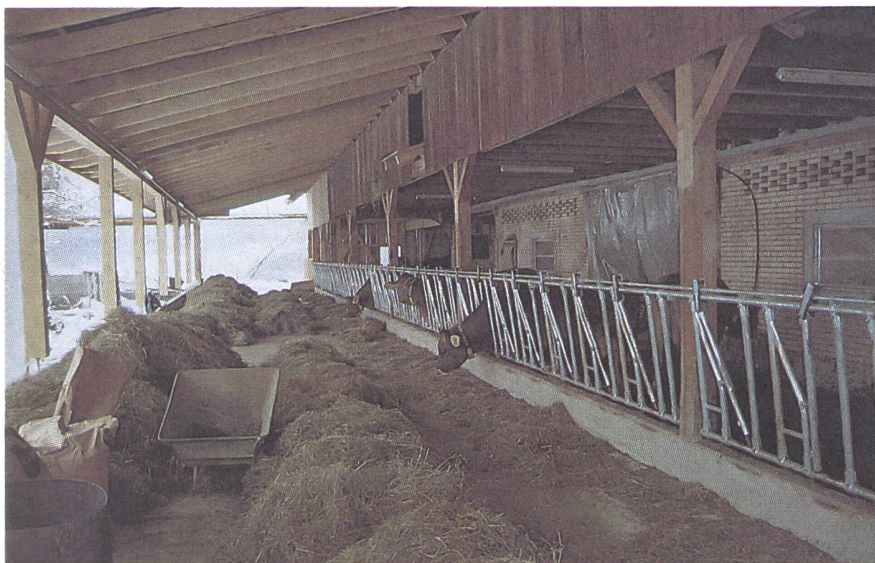
Stallerweiterung ohne Verschiebung des Grundrisses: Fressplatz unter dem ausladenden Scheunenvordach mit zusätzlich überdachter Futterachse. (Alle Bilder inklusive Titelbild Norbert Widmer, LMS Hohenrain LU)
