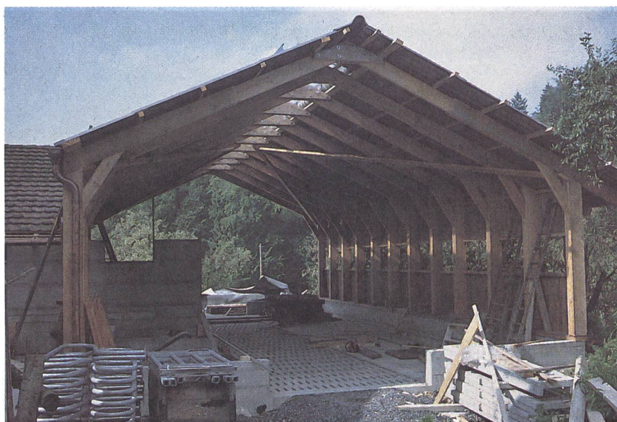
Klassisches Beispiel: Liegehütte mit Spaltenboden im Laufgang auf der neu erstellten Güllegrube.
