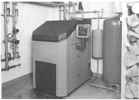
Stückholzheizkessel mit grosser oberen Beschickungstüre und seitlichem Bedienungstableau. (Foto: SCHMID)
