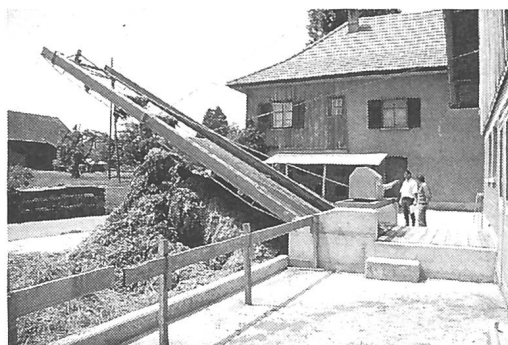
Der Mistschlitten fördert den Mist in der Verlängerung des Stalles direkt auf den Mistplatz.
