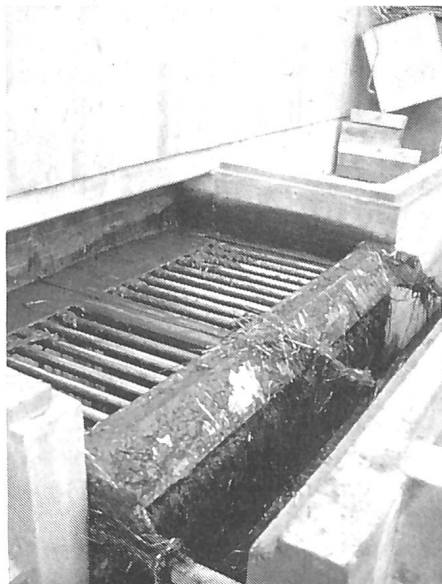
Beim Klappschieber mit horizontalem Drehmechanismus muss die gesamte Schieberbahn die gleiche Breite aufweisen.
