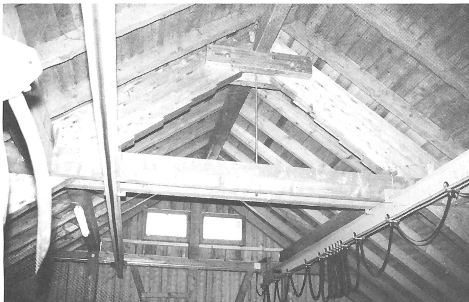
Abb. 4. Die alten Binder wurden weggenommen und durch Leimbinder ersetzt. Eine kostenaufwendige Lösung!
