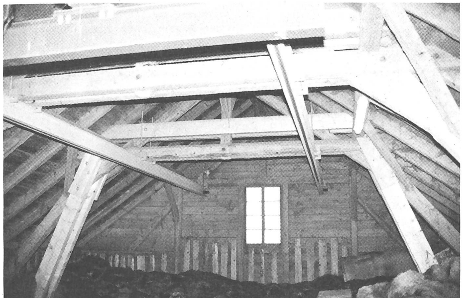
Abb. 3. Drehkran in einer bestehenden Scheune eingebaut. Neben einer zusätzlichen Zange wurden die Binder mit Streben bis auf den Boden verstärkt. In einem belüfteten Heustock sollte man solche Streben einwandern, um Luftverluste zu vermeiden.
