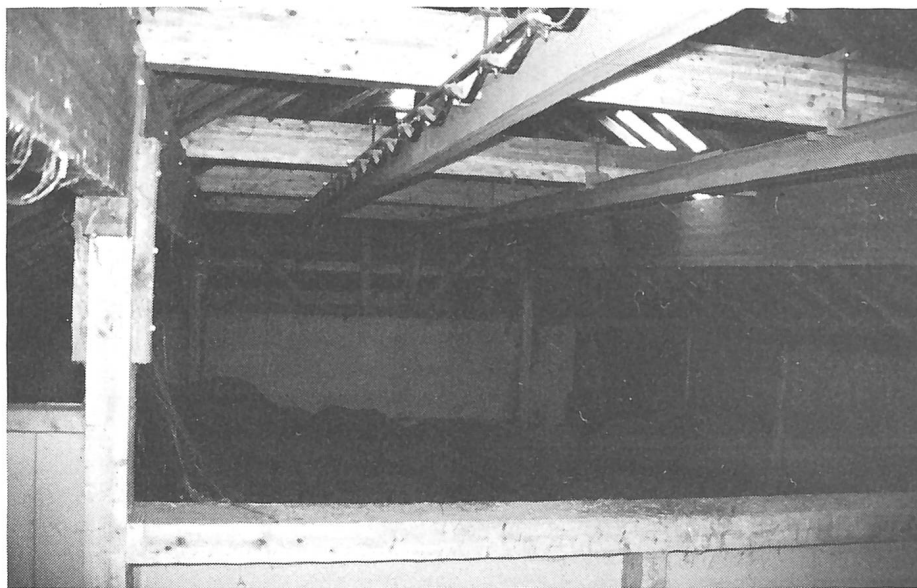
Abb. 5. Die Zange, an welcher der Drehkran montiert ist, stützt beidseitig auf einem verleimten Längsträger. Der Längsträger überspannt den Heustock (12 m).
