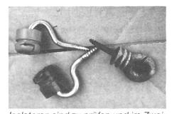
Isolatoren sind zu prüfen und im Zweifelsfall, vor allem beim Auftreten von Rissen, durch neue zu ersetzen.
