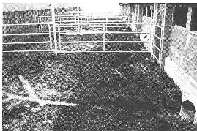
Abb. 12. Eine Teilüberdachung des Auslaufs schaffte bessere Bedingungen für Tiere. Nur noch dieser Teil ist mit Holzschnitzel versehen und wird gerne als Liegefläche genutzt. Die Reinigung der Restfläche erfolgt von Hand via Sammelshächte in die bestehende Grube unter dem Spaltenboden.
