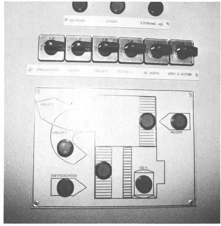
Abb. 3: Es lassen sich verschiedene Betriebszustände schalten. Diese werden durch Symbole und Signallampen dargestellt. Funktions- und Störanzeigeleuchten unterstützen den Landwirt.
