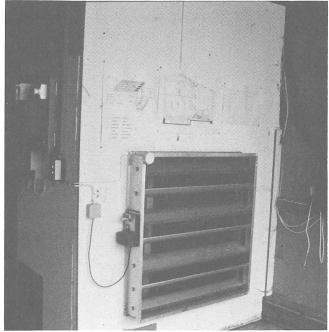
Abb. 4: Regelklappe mit Motorantrieb In Verbindung mit einem Steuergerät sorgt die Klappe, dass sich der Wärmespeicher nicht zu rasch abkühlt. Leider verursachen Klappe und Steuerung einen Investitionsbedarf von rund Fr. 3000.–, unabhängig von der Grösse des Speichers bzw. der Heubelüftungsanlage.
