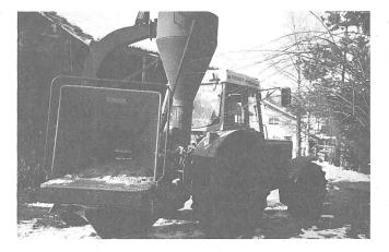
Motorenmaschinen sind zum Teil ebenfalls mit 360 Grad schwenkbarem Hackerteil lieferbar. Interessant für den Einsatz in Stadtgebieten sind die zwei Ausführungen mit Anti-
