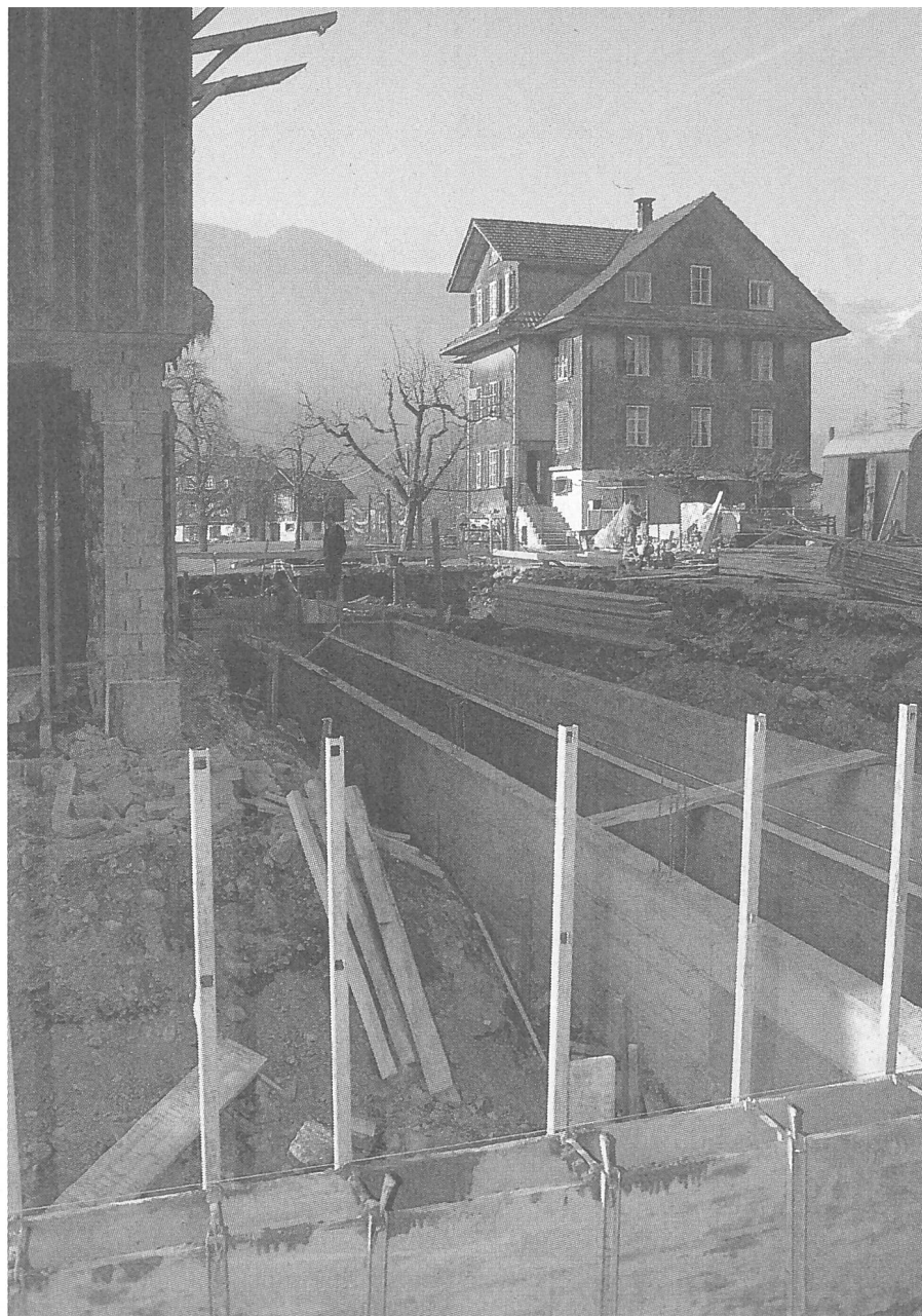
Eine Möglichkeit, kostengünstig zu bauen, besteht darin, von den Vorteilen zu profitieren, die sich durch die Zusammenarbeit mit einer Genossenschaft für landwirtschaftliches Bauen (GLB) ergeben. Diese Baugenossenschaften sind bei der SAB in Brugg (Tel 056/42 30 12) zusammengefasst. (Foto: Zw.)
