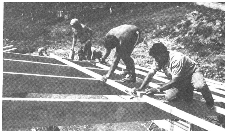
Die aufgerichteten Starrahmen-Binder werden mit der Dachlattung und Windverbänden sofort fixiert.
