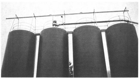
Zum Betrieb einer Siloentnahmefräse gehört ein Hebezeug für den Transport auf und in den Silo. Für eine Silobatterie eignet sich eine Krananlage am besten. Sichere Laufstege von Silo zu Silo sind unabdingbar.
