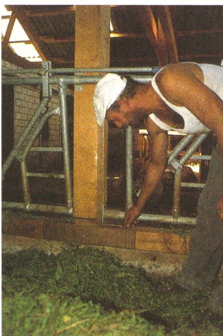
Korrosionsbeständige Abstützung der Binderfelder auf Hartholzelementen.
