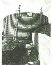
Dichter als Beton: Rotaver Güllensilos aus doppelt feuerverzinkten gewellten Stahlplatten, beidseitig kunststoffbeschich-
