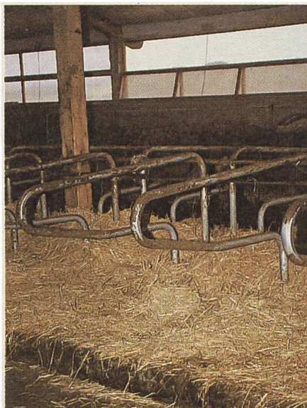
Damit leichter eingestreut werden kann, aber auch mit einem Gewinn an Komfort für die Tiere, wurden zur Boxunterteilung vorne befestigte Rohrbogen statt Stützen im hinteren Tierbereich gewählt.
