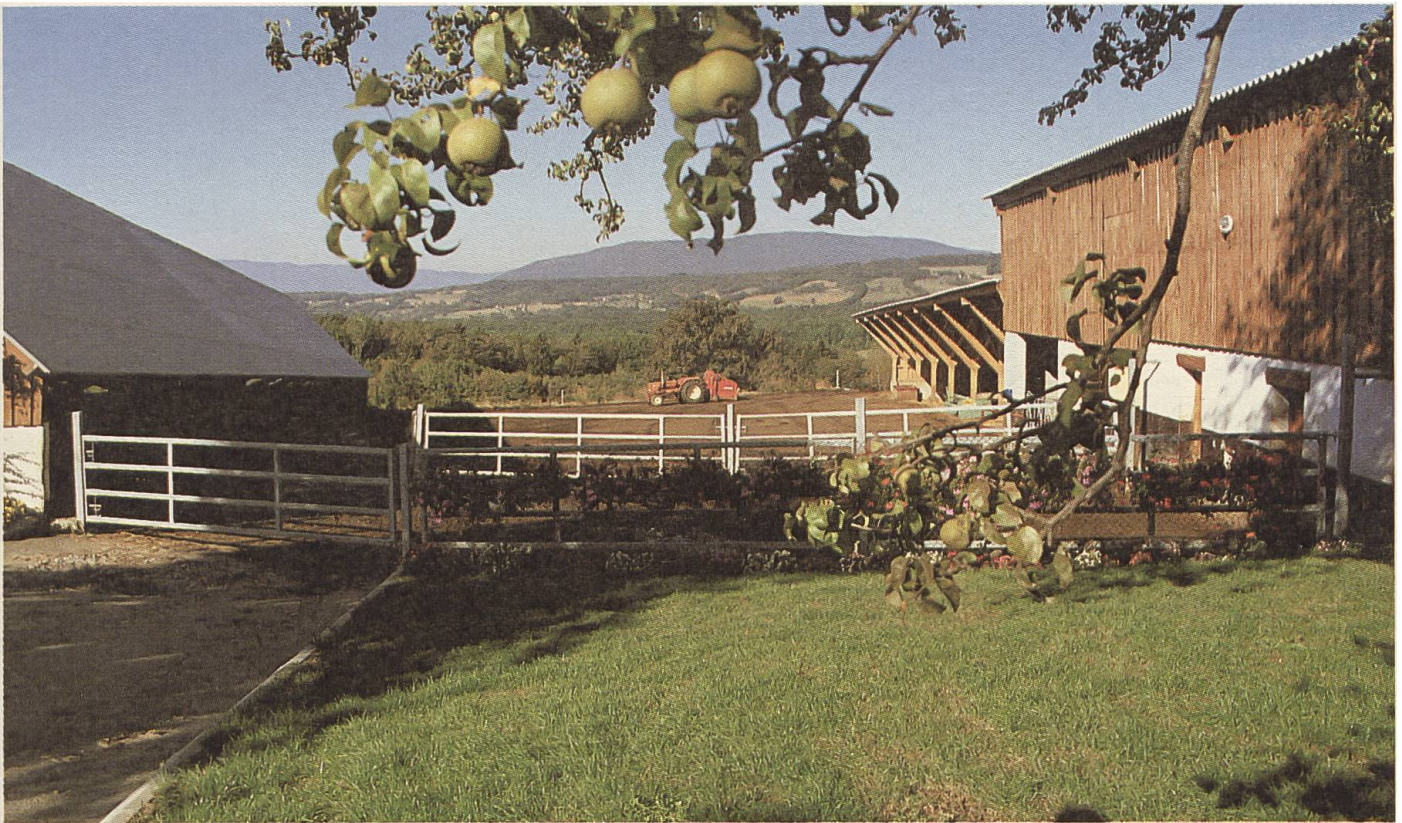
Grosszügige Hofanlage mit 10 m 2 Laufläche und 5 m 2 Liegefläche pro Kuh. Links Unterstand für die Fütterung mit mittig angeordnetem Futtertisch, rechts Tiefstreulager, ganz rechts Melkstand mit darüber angeordneter Kraftfutterstation.
