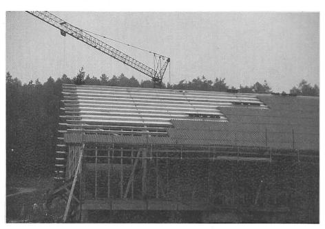
Abb. 11: Bei Neubauten empfiehlt es sich, die Spanplatten direkt vor dem Dachdecken zwischen die Balken zu verlegen.
