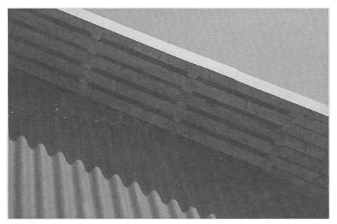
Abb. 12: An windexponierten Lagen oder aus ästhetischen Gründen können auch Bretter auf die hier gezeigte Art montiert werden. Allerding ist darauf zu achten, dass die gesamte Schlitzbreite mindestens der Kanalhöhe entspricht.
