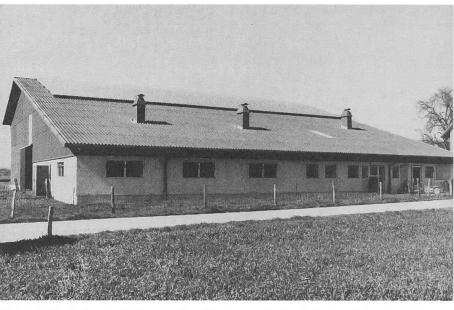
Abb. 14: Ein Aufbaukollektor aus Alu-Blech, montiert auf eine bestehende Scheune. Die zweite Pfettenlage kommt auf das bestehende Eternitdach zu liegen. Dieses ist nur in der Mitte unterbrochen, damit die Luft in den darunter liegenden Sammelkanal einströmen kann.
