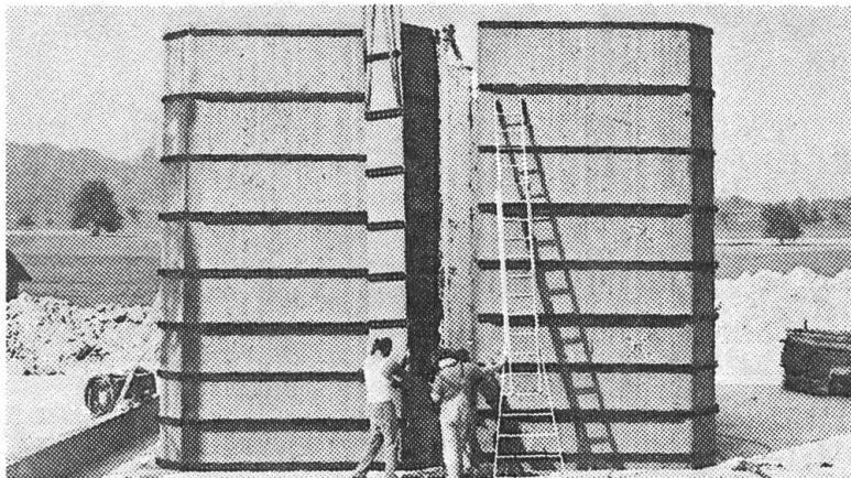
4-Eck-Silo mit 50 cm gebrochenen Ecken, mit Futtertür oder Lukenband. Elementbausystem nach Mass, in sehr stabiler Bauweise, dazu verwenden wir feinjähriges Schwedenfichtenholz. Schnelle Montage. Grosse m<sup>3</sup>-Zahl auf kleiner Fläche. Lange Lebensdauer.
