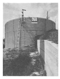
Dichter als Beton: Rotaver Güllensilos aus doppelt feuerverzinkten gewellten Stahlplatten, beidseitia kunststoffbeschich-Für jahrzehntelangen Einsatz ohne Probleme. Einfach und rasch zu montieren und bei Bedarf aufzustocken oder zu versetzen. Im Baukastensystem mit Durchmessern von 6-23 m und 50-1500 m3 Inhalt.
