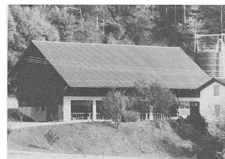
Modernes landwirtschaftliches Ökonomiegebäude (im Kanton Solothurn) mit DV-druckimprägnierter Hegner-Fichtenaussenschalung und Hegner-Siloanlage aus DV-druckimprägniertem Föhrenholz.
