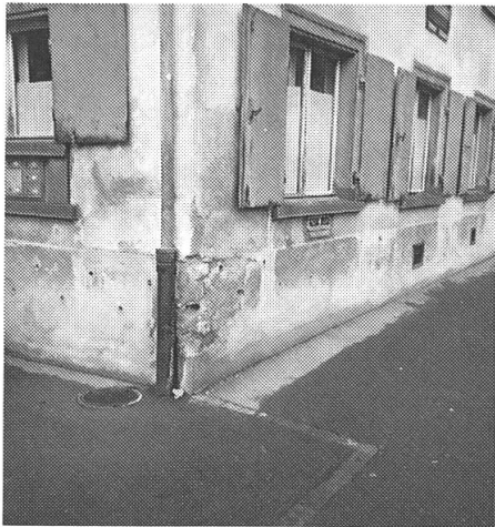
Vor Ausführung der Elektroosmose-Mauerentfeuchtung 1980.
