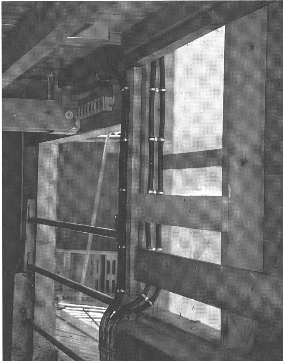
Hydraulikleitungen zwischen zentraler Ölpumpe und den Hydromotoren für das Entmistungssystem.
