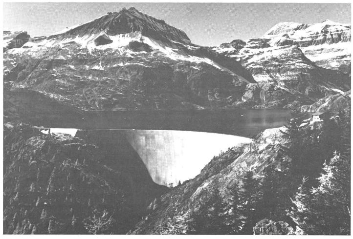
Mit der Speicherung von Wasserkraft in unseren alpinen Stauseen können im Sommer anfallende Wasserzuflüsse zur Produktion im Winterhalbjahr, das versorgungsmässig den Engpass bildet, verlagert werden. (Im Bild die Staumauer und der Stausee Emosson im Wallis mit einem Inhalt von 225 Millionen m³ Wasser.)
