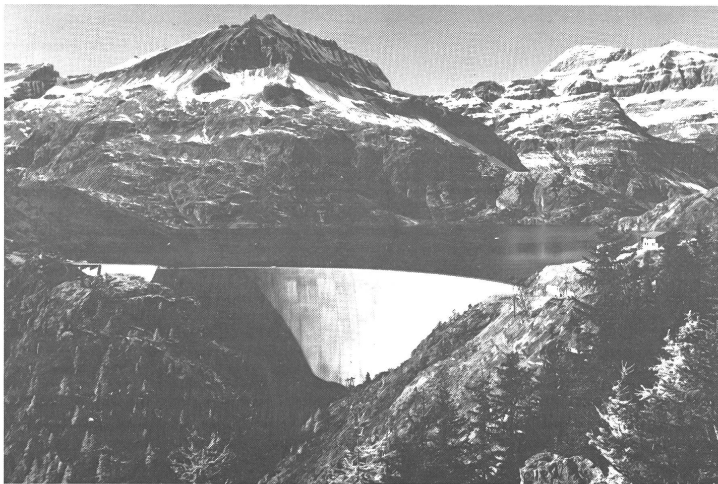
Mit der Speicherung von Wasserkraft in unseren alpinen Stauseen können im Sommer anfallende Wasserzuflüsse zur Produktion im Winterhalbjahr, das versorgungsmässig den Engpass bildet, verlagert werden. (Im Bild die Staumauer und der Stausee Emosson im Wallis mit einem Inhalt von 225 Millionen m 3 Wasser.)
