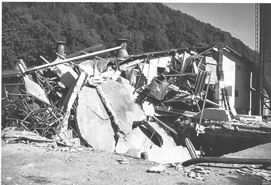
Abb. 1: Das kann passieren, wenn Gase in einer Güllegrube explodieren!
