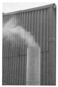
Abb. 7: Abluftkamin mit 40 cm Durchmesser (links). Der Rauch zieht durch das Kamin nach aussen weg (rechts). Eine Alternative zum Gitterrost...
