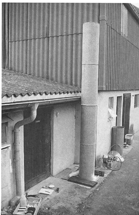
Abb. 7: Abluftkamin mit 40 cm Durchmesser (links). Der Rauch zieht durch das Kamin nach aussen weg (rechts). Eine Alternative zum Gitterrost...
