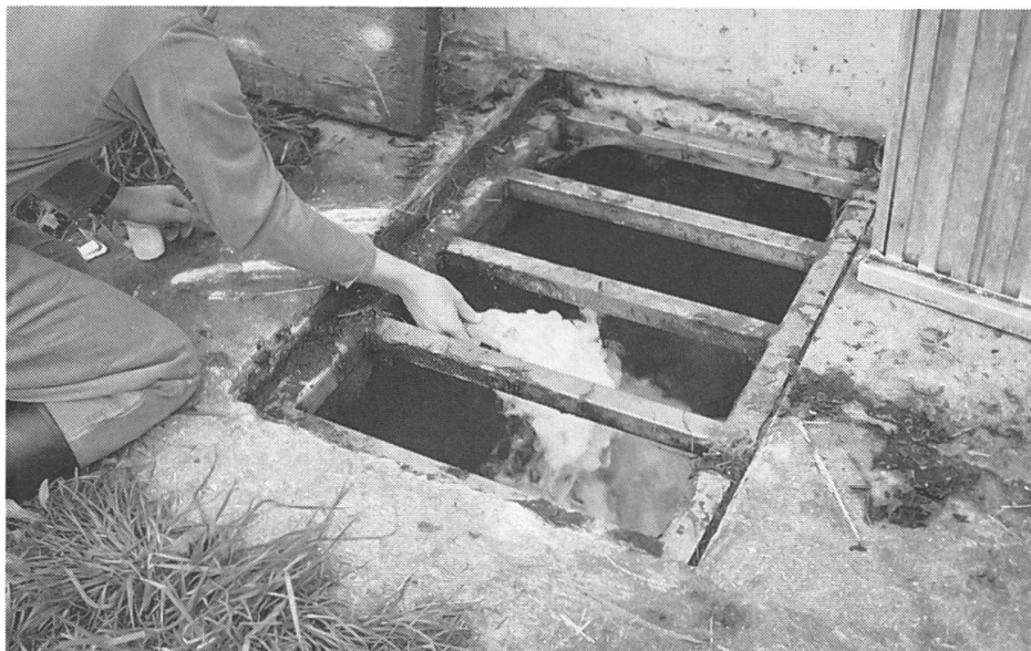
Abb. 10: Bei der Entlüftung mit Ventilator wird die Luft auf der einen Öffnungsseite angesaugt...
