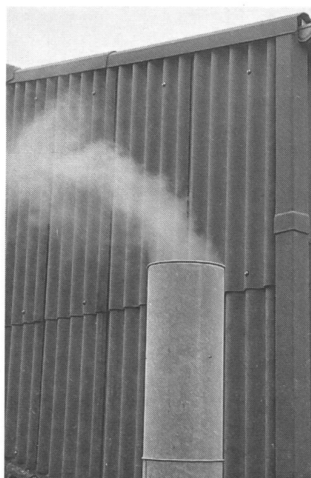
Abb. 7: Abluftkamin mit 40 cm Durchmesser (links). Der Rauch zieht durch das Kamin nach aussen weg (rechts). Eine Alternative zum Gitterrost...
