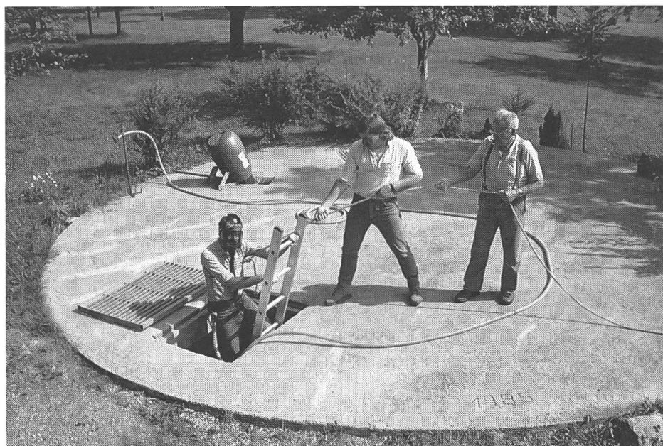
Nur durch zwei Personen gesichert in eine Güllegrube einsteigen. Für kleinere Arbeiten eignet sich ein Frischluftgerät (bei den meisten Landwirtschaftlichen Schulen erhältlich). Bei grösseren Arbeiten (z.B. Reinigung der Grube) Ventilator einsetzen.
