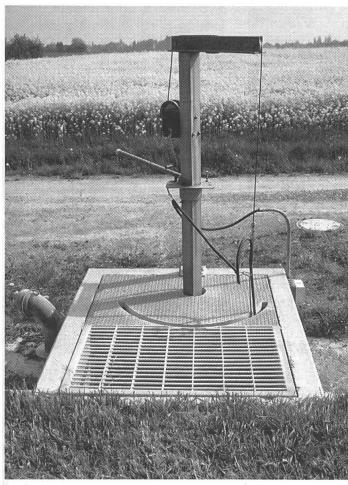
Stationäre, von aussen zugängliche Rührwerke, massive Abdeckungen der Montage- und Entlüftungsöffnungen und feste Ansaugstutzen helfen Unfälle verhüten und erleichtern die Güllearbeiten.
