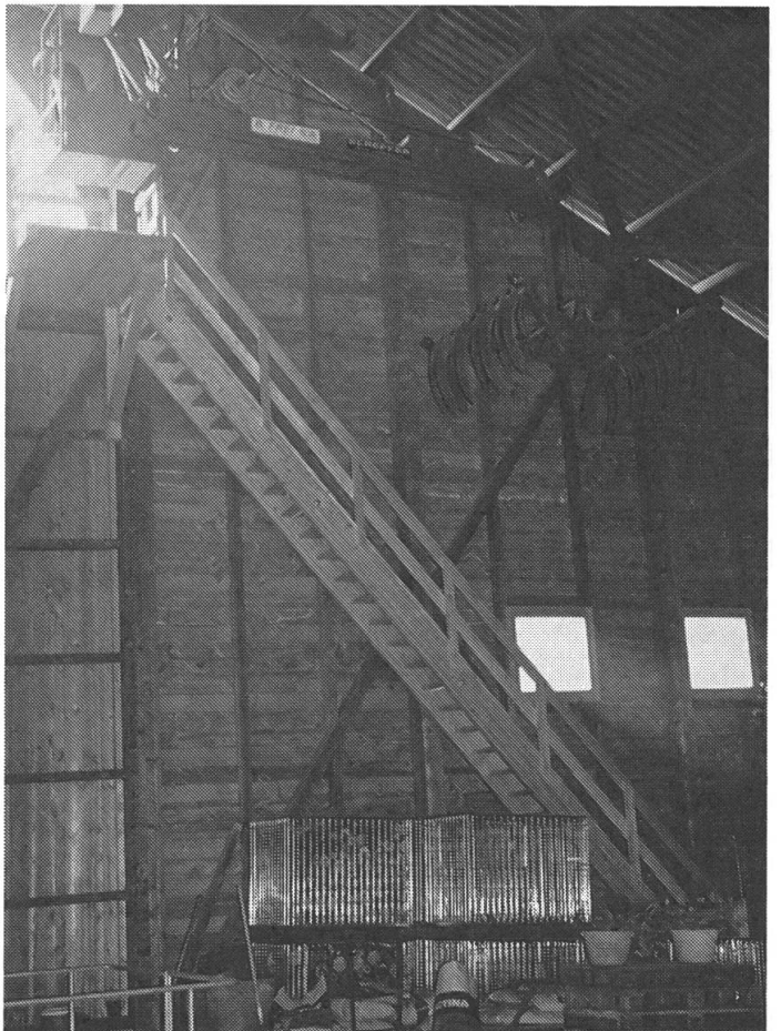
Eine häufig mögliche Lösung: Kranaufstieg an der Stirnseite der Gebäude.
