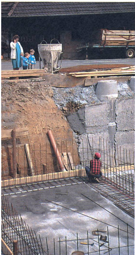
Interessierte Gäste an der Baugrube.
