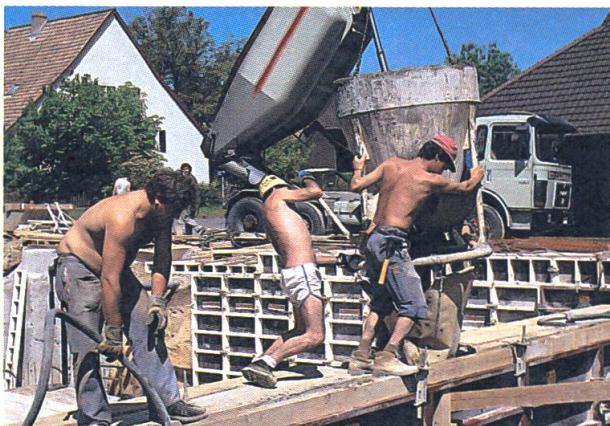
Der Fachmann erkennt die neue Schalungstechnik.
