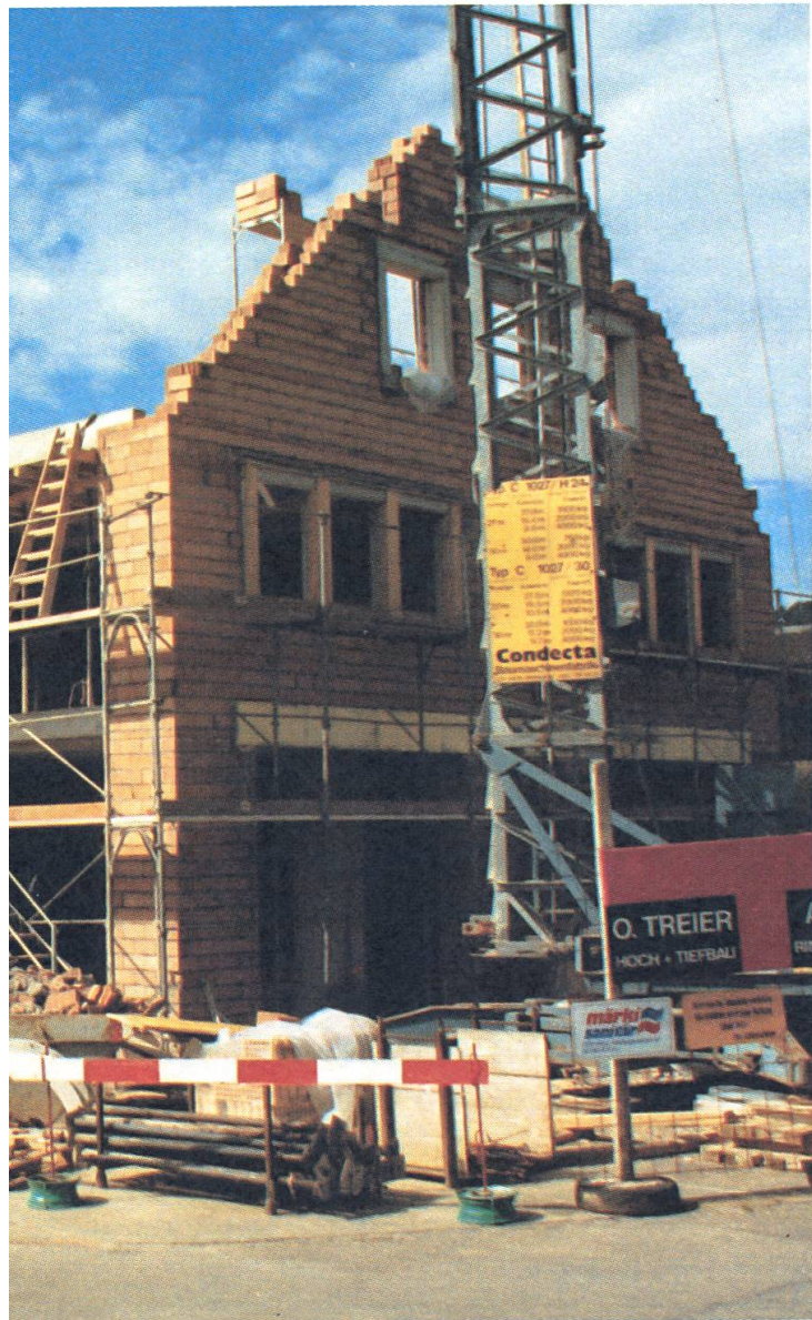
OPTITERM – eine neue Backsteingeneration mit besserer Wärmedämmung.
