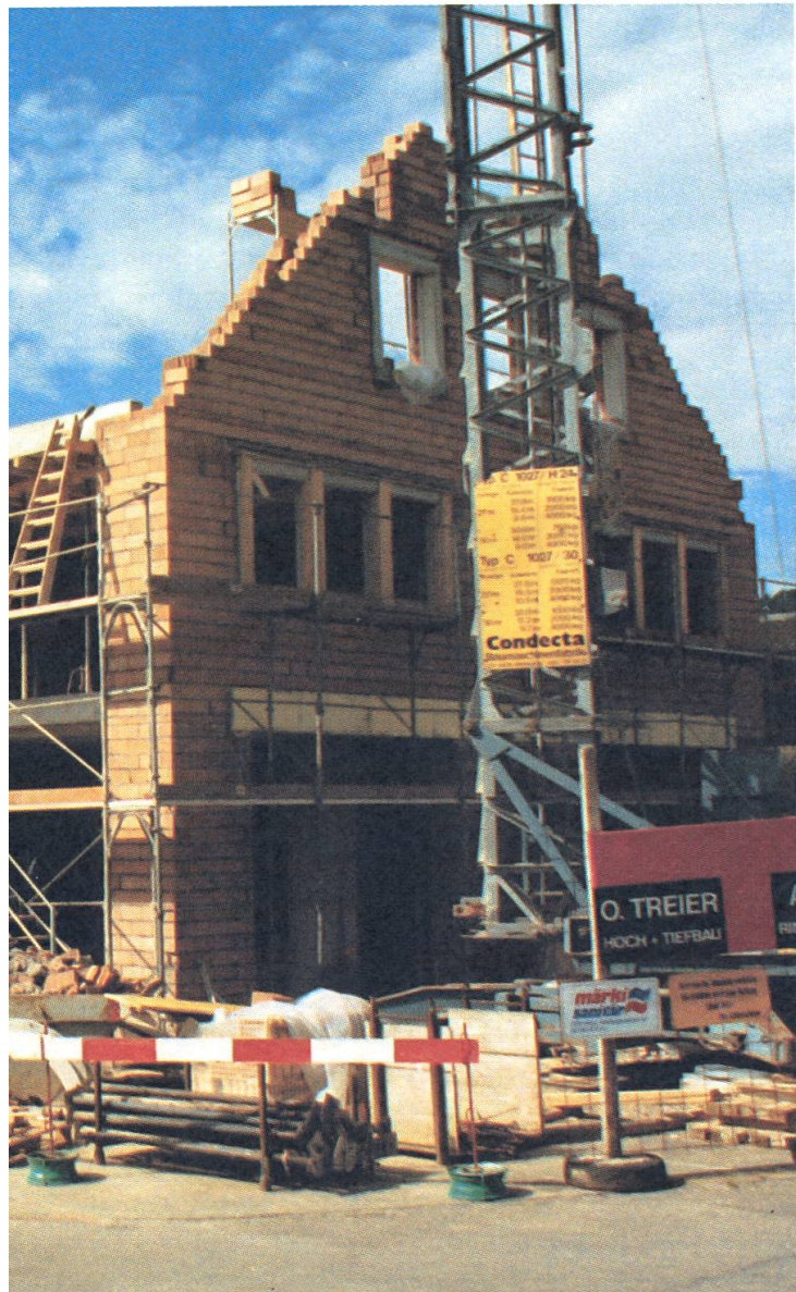
OPTITERM – eine neue Backsteingeneration mit besserer Wärmedämmung.
