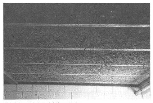
Abb. 2: Heraklithplatte als Lüftungsdecke.
