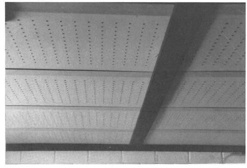
Abb. 3: Lochdecke als Lüftungsdecke.
