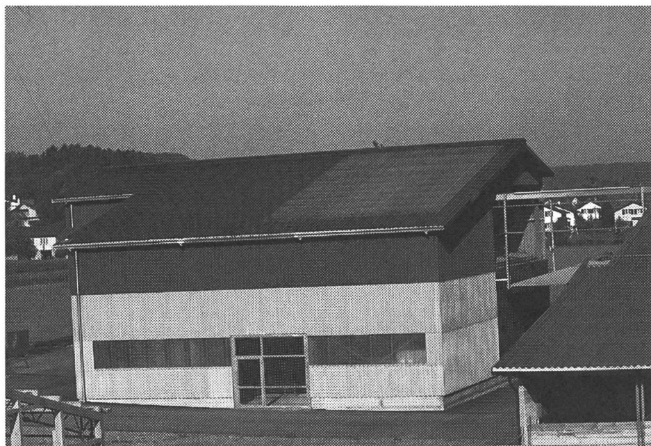
Abb. 2: Die linke Dachseite besteht aus einem Blechkollektor (A) mit 118 m 2 , die rechte aus einem Kunststoffkollektor (B) mit 71 m 2 und einer Blechumrandung von 27 m 2 .
