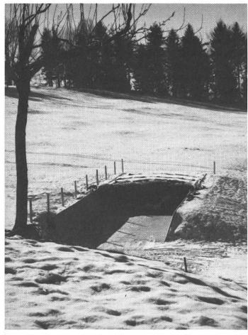
Das Zürcher Oberland ist ein bevorzugtes Naherholungsgebiet. Dass ein Fahrsilo das Landschaftsbild übermässig stört, düfte bei diesem Anblick niemand behaupten. Um den Sickersaft abzuleiten, musste in diesem Fall ein Sickerschacht von einem Kubikmeter Inhalt erstellt werden.
