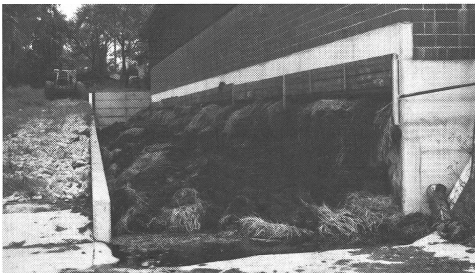
... wobei der Tretmist durch regulierbare Schlitzöffnungen in der Rückwand selbsttätig in die Mistgrube befördert wird.
