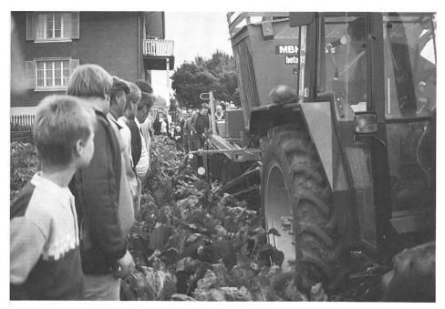
Die Rüben werden am Kraut durch zwei Riemen aus dem Boden gehoben.
