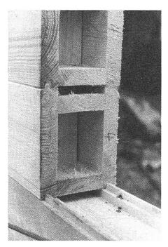
Die Blumen-Träger bestehen aus vier verleimten Brettern. Mit Hilfe von Nut und Kamm können sie millimetergenau zusammengefügt werden. Die Aussenbretter sind zugleich fertige Wand bzw. fertige Decke. Die Wärmeisolation ist ausgezeichnet.
