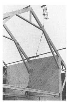
Auch die Heustockwände werden am Boden vorgefertigt und als ganzes mit dem Baukran eingehängt.
