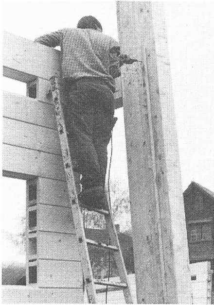
Zusammenbau der vorgefertigten Wände und Hauptträger.
