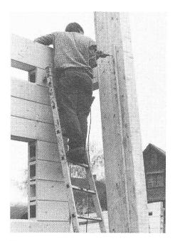
Zusammenbau der vorgefertigten Wände und Hauptträger.
