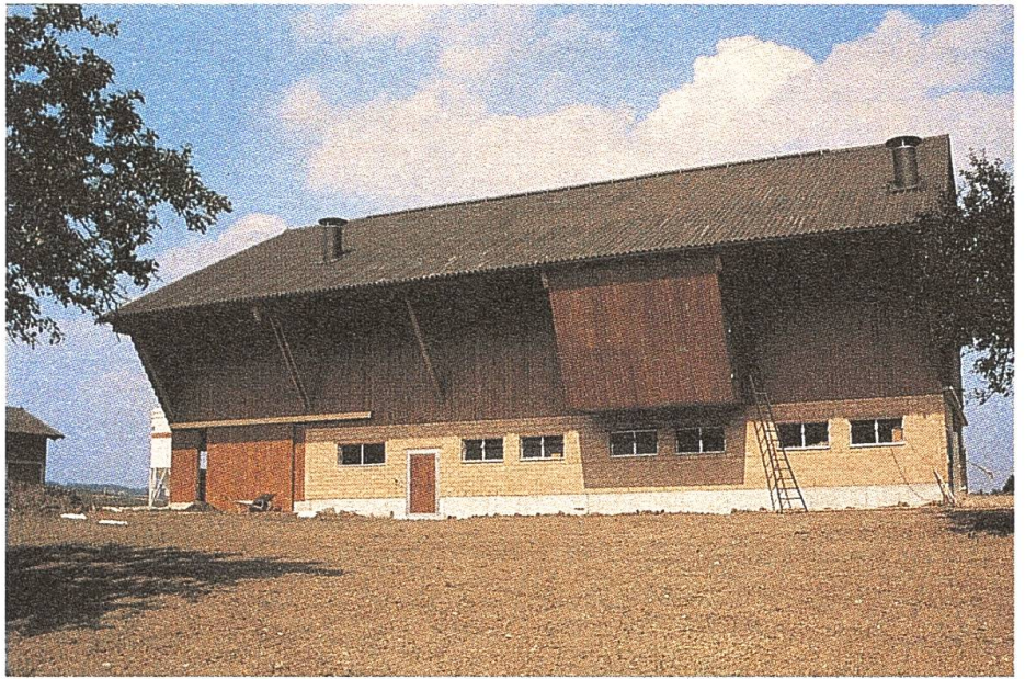
Sonnenkollektoren reduzieren den Energieverbrauch für die Heubelüftung um rund einen Drittel. Die Kollektortechnik ist heute praxiserprobt und zum Inbegriff des rationellen Energieeinsatzes in der Landwirtschaft geworden.
