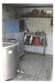
Wärmerückgewinnung bei der Milchkühlung: Die von der Kühlmaschine freigesetzte Wärme wird zur Temperierung von Brauchwasser genutzt.
