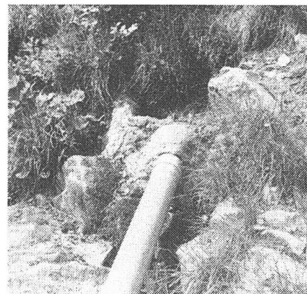
Abb. 5: Quellenfassung: Das Wasser wird unmittelbar nach seinem Austritt durch eine Betonschale gefasst und in ein PCV-Rohr (Aussendurchmesser 110 mm) geleitet.
