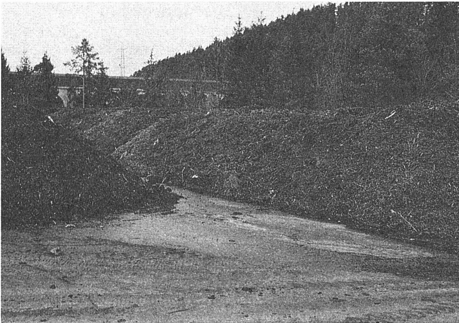
Der Kompostierplatz muss unbedingt befestigt sein, damit das Sickerwasser gefasst und der Kläranlage zugeleitet werden kann, bzw. die Arbeitsmaschinen manövriert werden können.
