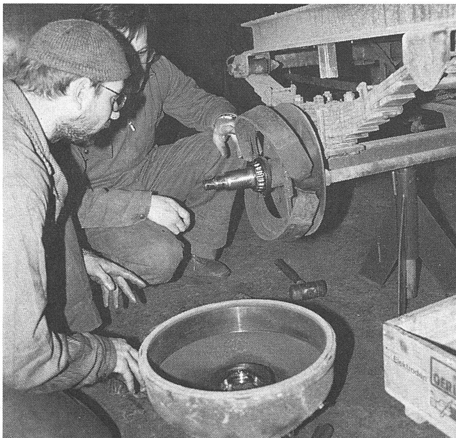
... funktionstüchtige Bremsen von grossem Nutzen sind. Im Rahmen eines Kurses des SVLT werden abgenützte Bremsbeläge durch neue ersetzt.
