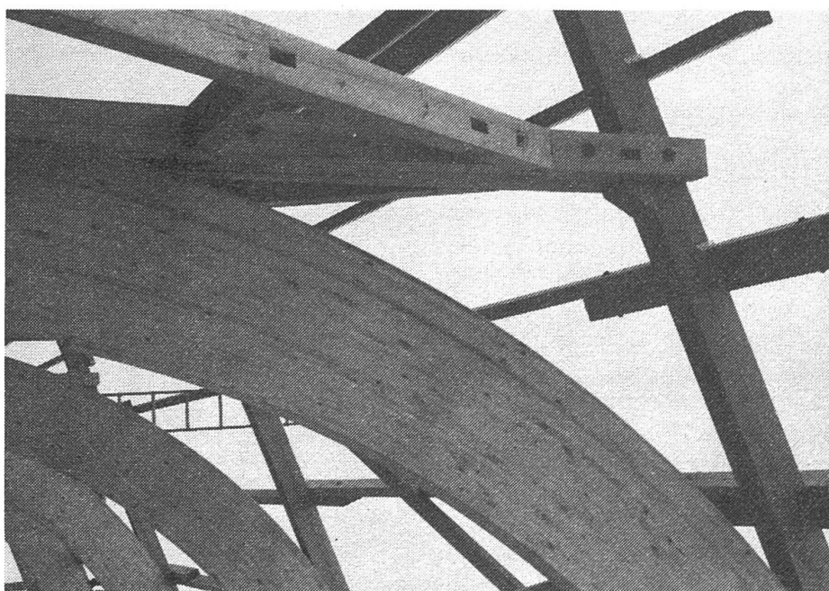
Hetzerbalken haben sich seit 80 Jahren auf dem Bau bewährt. Mit der Verleimung kann man sehr grosse und allenfalls gebogene Balken herstellen.
