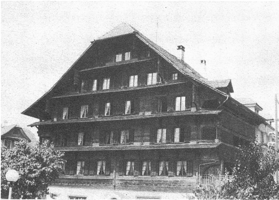
Dieses uralte Haus in Sarnen hat dank dem vorbildlichen Witterungsschutz (grosse Vordächer und Klebedächer) Jahrhunderte überlebt. Der Baustoff ist Holz.
