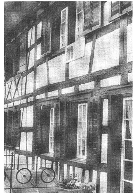
Holzfenster und Holztüren haben eine lange Lebensdauer, wenn sie in die Fassade eingelassen und vor Regen geschützt sind. In unserem Klima sind Fensterläden eine Notwendigkeit.
