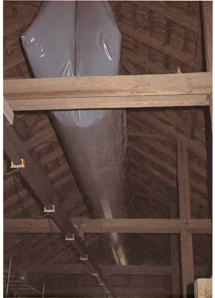
Abb. 4: Gassack (Lunge) in einem Altgebäude.
