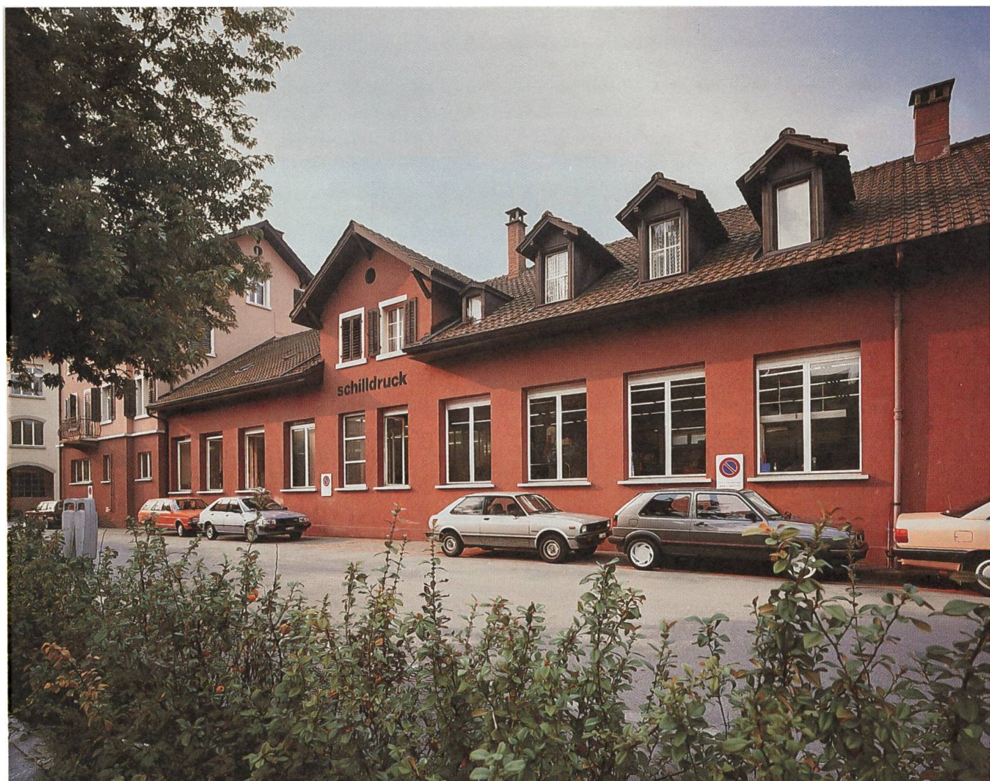
Schilldruck an der Sentimattstrasse in Luzern
