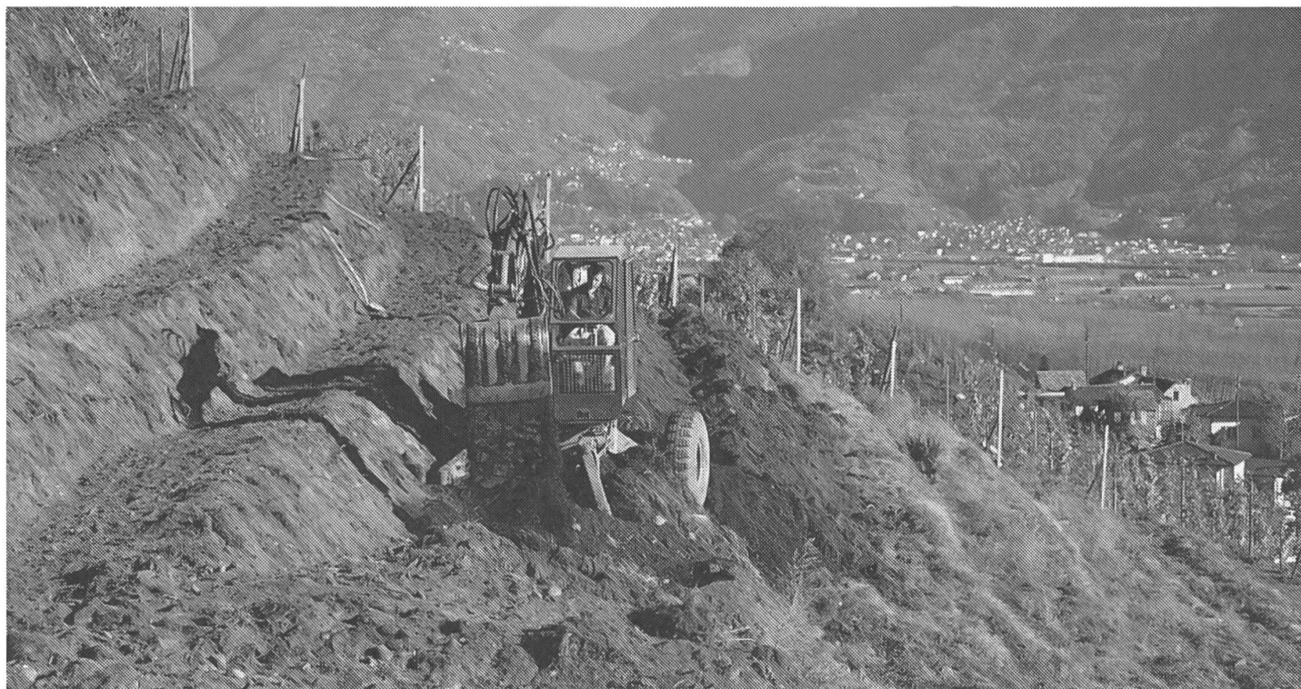
Der Rebberg der «Sottostazione» von Cadenazzo wird systematisch terrassiert. Um Erosionsschäden vorzubeugen, darf die maximale Neigung der Böschung höchstens 200% betragen. Die Neuanlage eines Rebberges ist mit ca. 1200 Franken pro Are und der Durststrecke während der ersten vier Jahre ein kostspieliges und risikoreiches Unterfangen.
