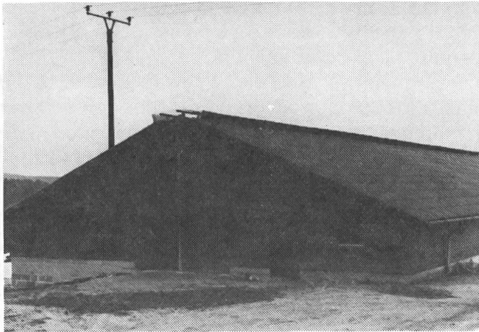
Giebelansicht des Stallgebäudes. Die Dachneigung von 24° ergibt eine niedrige Traufhöhe mit einem günstigen Mikroklima im Tierliegebereich.
