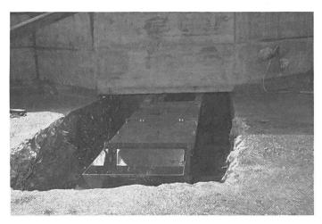
Abb. 3: Mistaustritt-Öffnung aus der Druckkammer nach oben.
