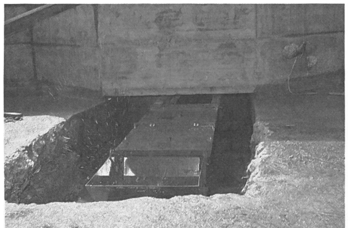
Abb. 3: Mistaustritt-Öffnung aus der Druckkammer nach oben.
