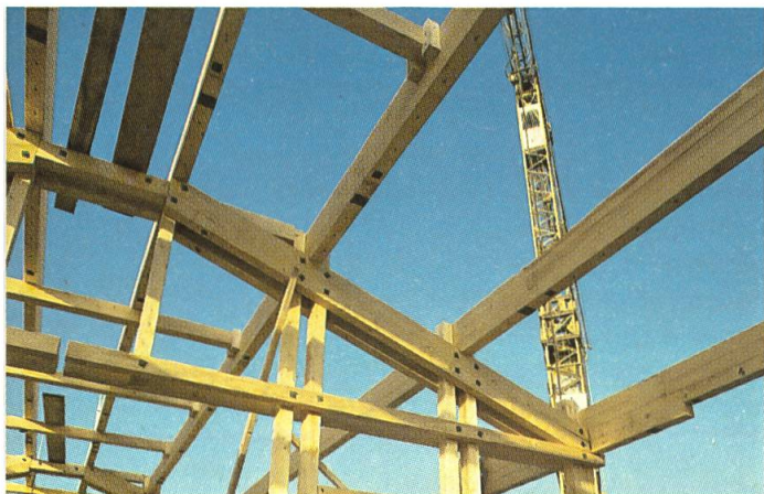
2: Mechanisch verbundene Kantholzquerschnitte
