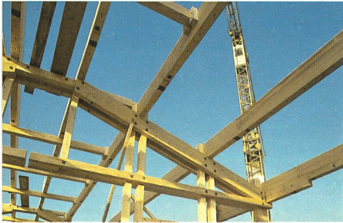
2: Mechanisch verbundene Kantholzquerschnitte
