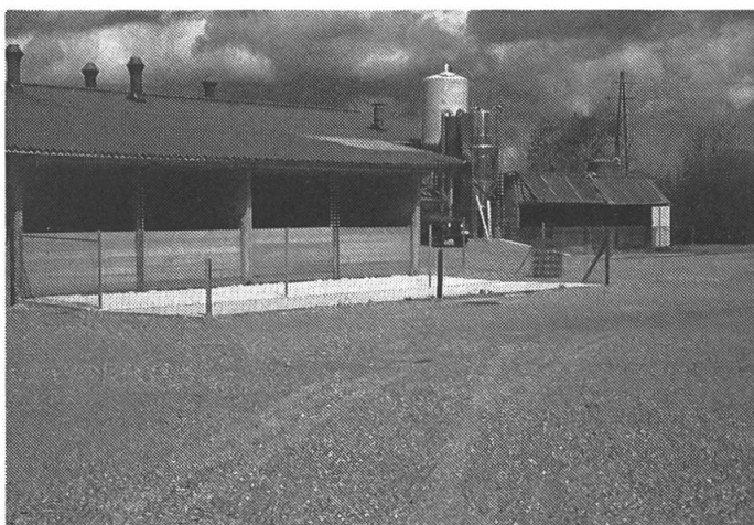
Abb. 4: Ein 7 m breiter befestigter Vorplatz vor dem Offenfrontstall gewährleistet ein sauberes Arbeiten beim Ausmisten.
